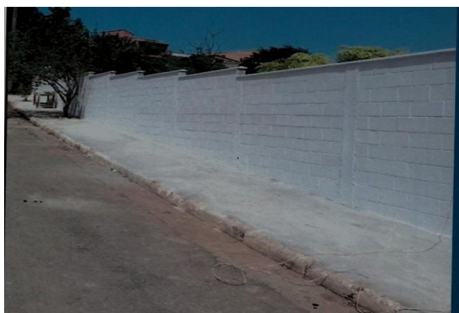
Muro UBS Jurema
