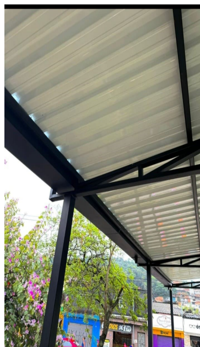
Telhado UBS Recreio São Jorge
